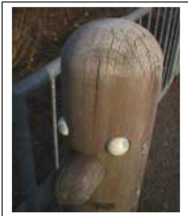
Holz trocknet über Hirn – nämlich die dort angeschnittenen Fasern und Wasserleitungsröhren besonders schnell aus; viel schneller als über die längs angeschnittenen Leitungsbahnen der Seitenflächen. Deshalb werden bei Hirnholz sehr schnell die Festigkeitskräfte des Holzes überschritten und das Holz bekommt „Hirnrisse“.
