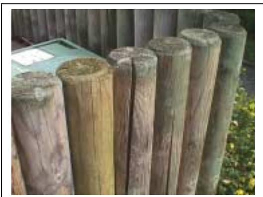
Trockenrisse in Rundhölzern wie Palisaden, Pfählen sind produkt- und holzanatomisch unvermeidbar. Einzelne Risse reichen in der Regel bis zum Mark. Die Risse beeinträchtigen nicht die Stabilität der Palisaden.
