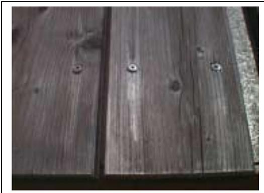
Bei Fassadenbretter sind ohne intakten Oberflächen-Wetterschutz Risse und ein Verzug der Bretter unvermeidbar. Sie entstehen zwangsläufig durch das stetige Arbeiten des Holzes, hervorgerufen durch wechselnde Holzfeuchten im Zusammenhang mit dem jahreszeitlichen Klimawechsel. Die Funktion als Fassadenbrett wird durch diese normalen Verwitterungserscheinungen in aller Regel nicht beeinträchtigt.
